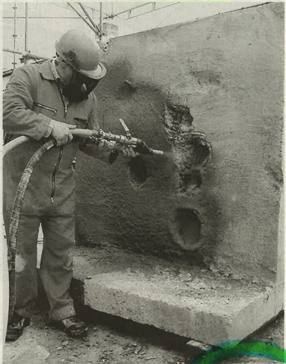
Neueste Instandsetzungsverfahren erleichtern die Arbeit des Beton-Instandsetzers.
